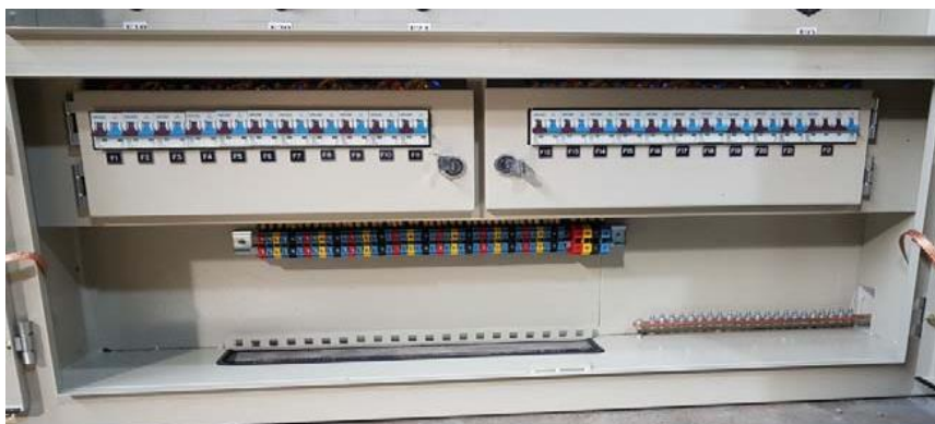
شکل ۴: روبند کلیدفیوزهای مینیاتوری خروجی
