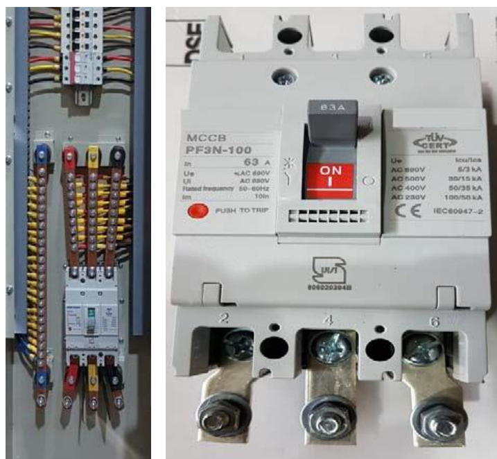
شکل ۳: الف) شینه‌های فابریک ب) شینه‌های کمکی کلید اتوماتیک
